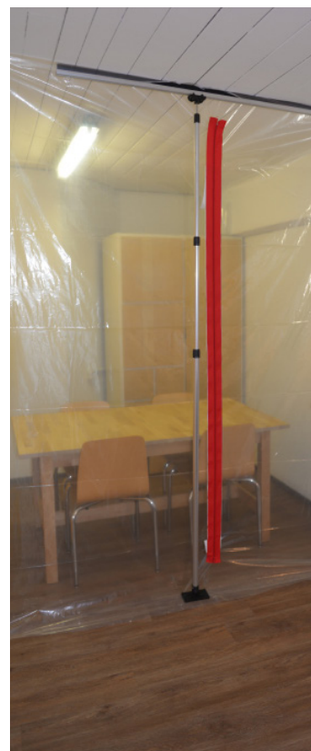
Befestigung der Folie am Boden und mit Federspanner an der Decke Fixation du film au sol et au plafond avec tendeur à ressort
