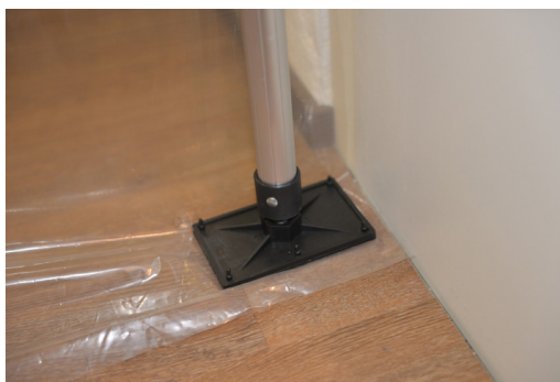
Befestigung der Folie am Boden und mit Federspanner an der Decke Fixation du film au sol et au plafond avec tendeur à ressort
