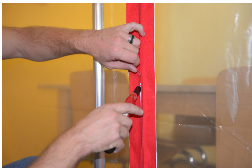
Reissverschluss kleben, Folie schneiden Collage zippé, découpe de film
